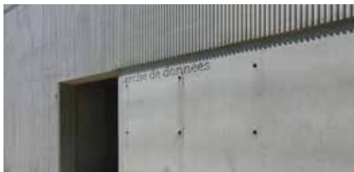
Data center du site INRA
